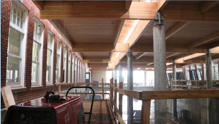
Completing Central Commons Area
